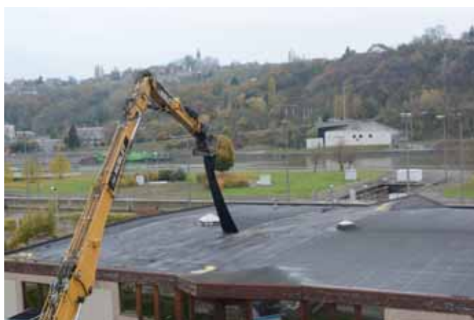
Enlèvement d'une ancienne membrane
